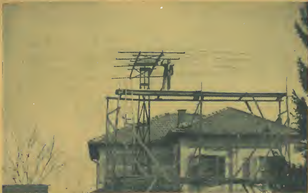
Fig. 1 - La prima edizione della "rotary beam", di I I RM, 4 elementi per 20 m e 4 elementi per 10 m "close spaced", radiatore "folded dipole".
