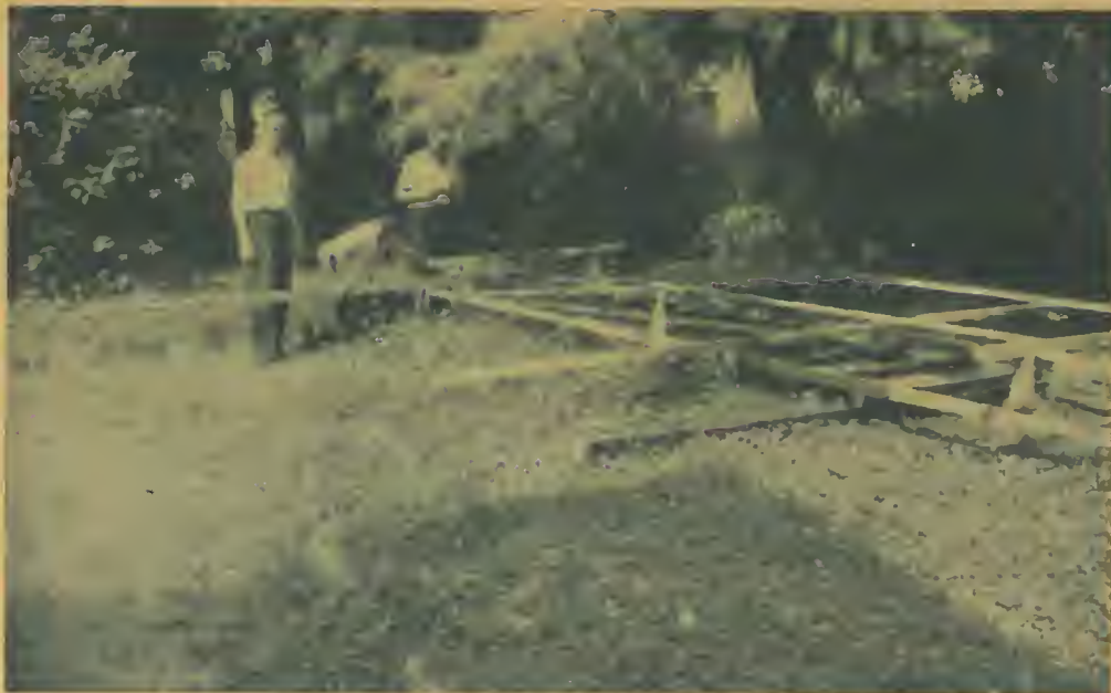
Fig. 2 - La culla o terra per il montaggio dei tubi, il primo a sinistra è T RM; in ginocchio T AY e il terzo è T DB
