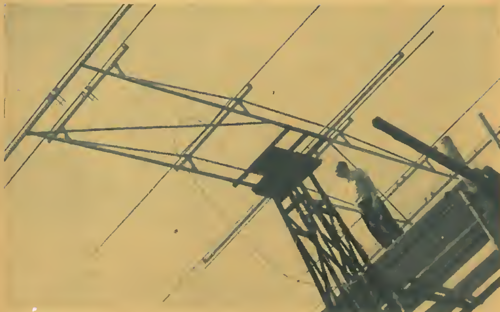
Fig. 8 - Come è montata la nuova culla sulla seconda edizione "wide spaced", - I 1 RM se l'ammira certo compiaciuta
