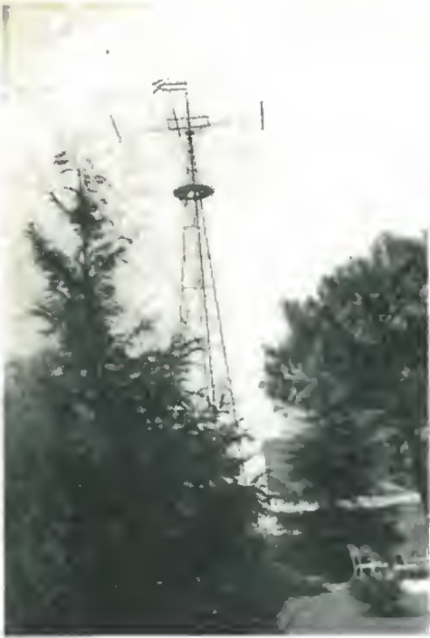
Antenna a 3 elementi per 20 m, di CX2 CL - Montevideo; altezza 24 metri, costruita su dati trasmessi via radio da IIR M
