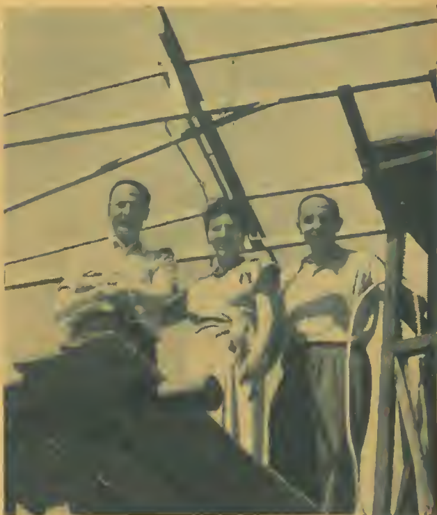
Fig. 9 - XYL-RM col marito e l'AY sulla impalcatura provvisoria a m. 11 da terra
