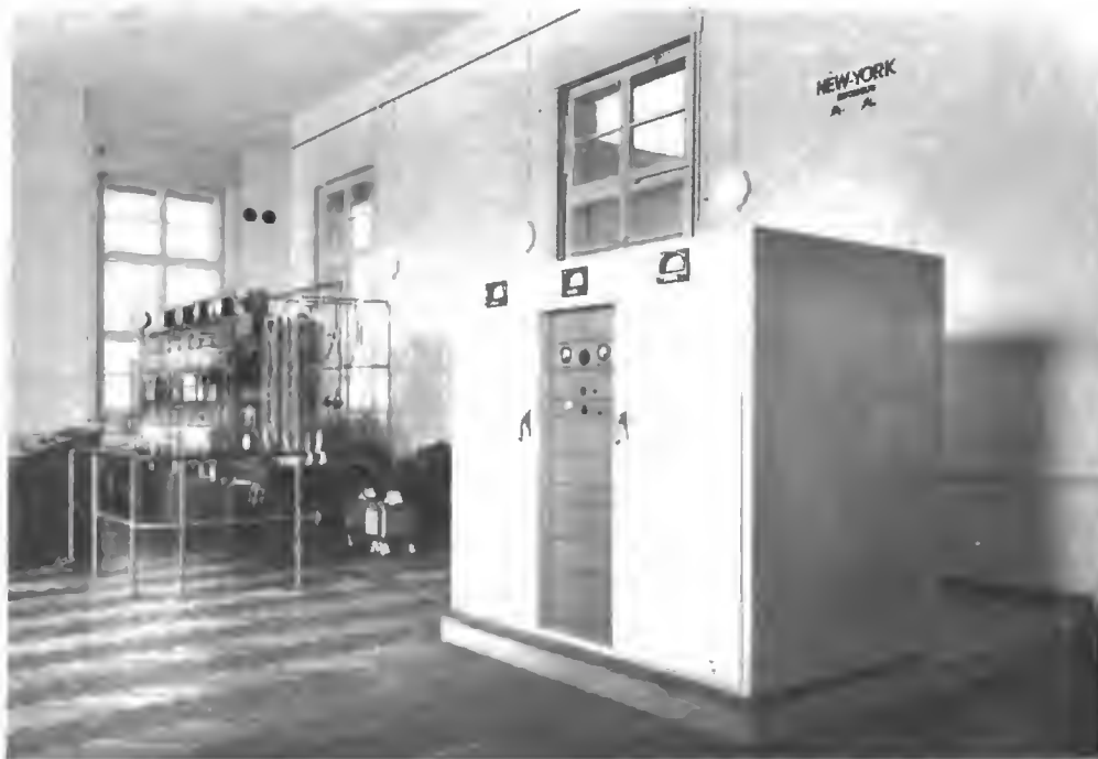
Fig. 3. - Trasmettitore telegrafico SO 58/10 K in esercizio presso la Società per la Telegrafia commerciale « Radio Svizzera » di Münchenbuchsee. - In fondo: L'amplificatore alta frequenza di un trasmettitore ad onde lunghe 6 kW, di costruzione anziana.
