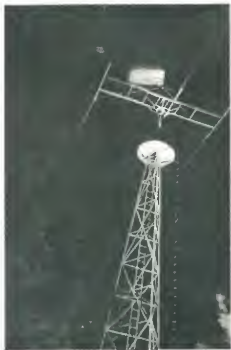
Antenna a 3 elementi per 20 m, di CX2 CL - Montevideo; altezza 24 metri, costruita su dati trasmessi via radio da IIR M
